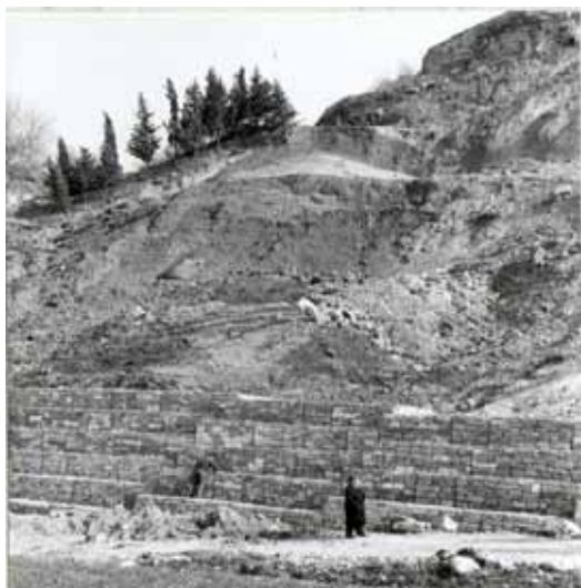
Costruzione gabbionate al piede della Frana
