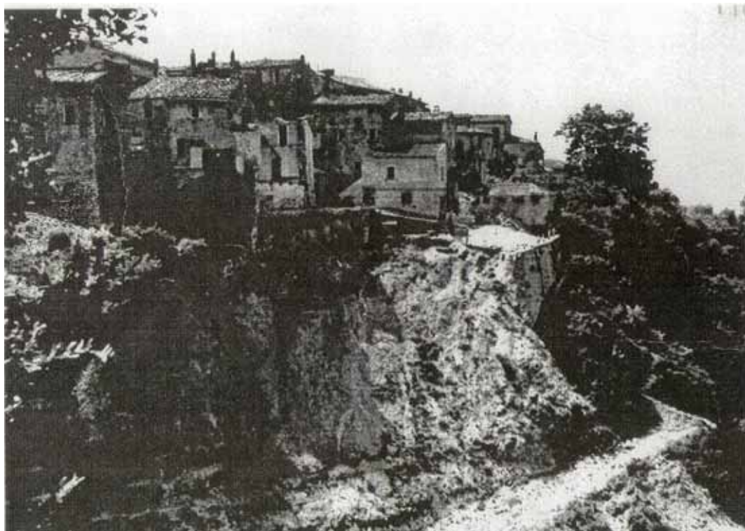
Frana zona della Portella 1960 con crollo del muro di contenimento
